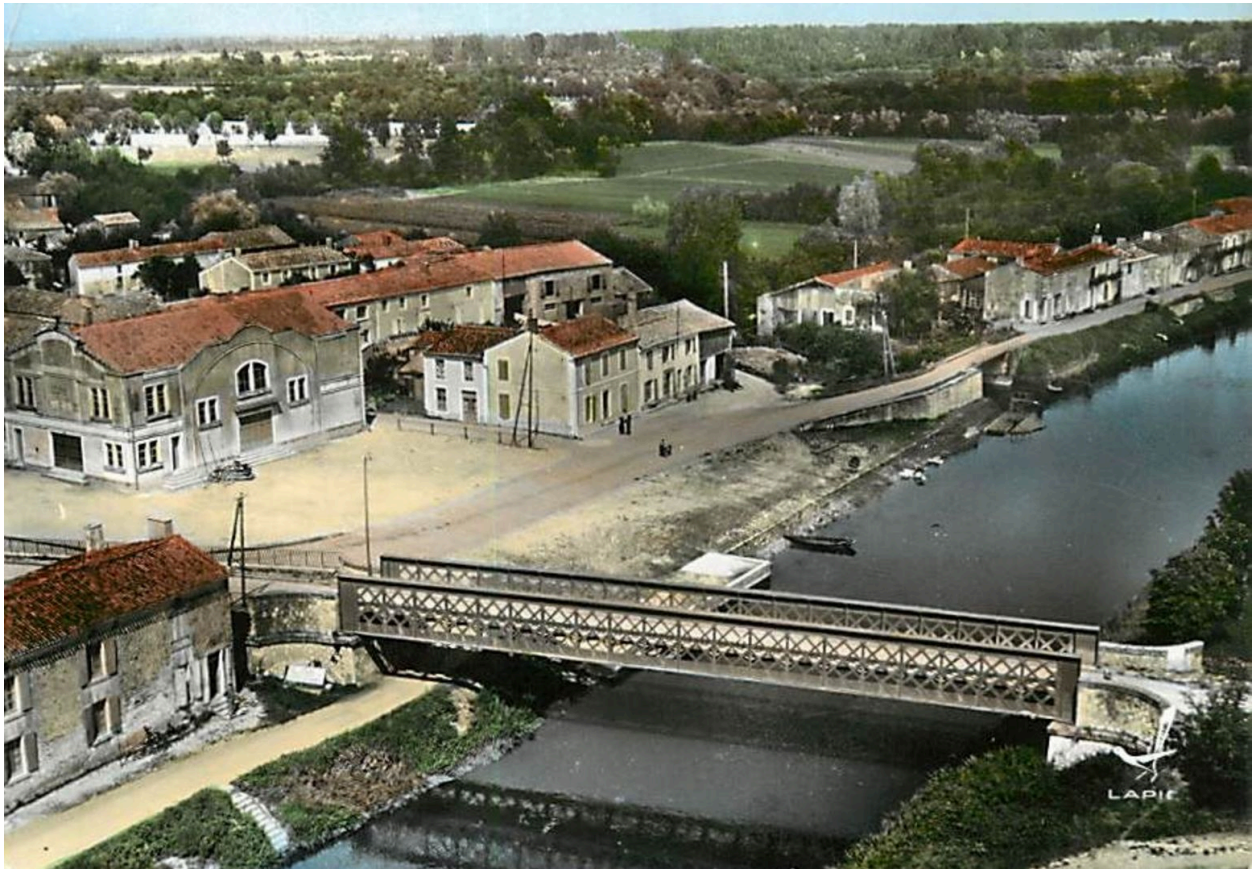
Vue aérienne du pont et de ses abords depuis l'ouest vers 1960.
