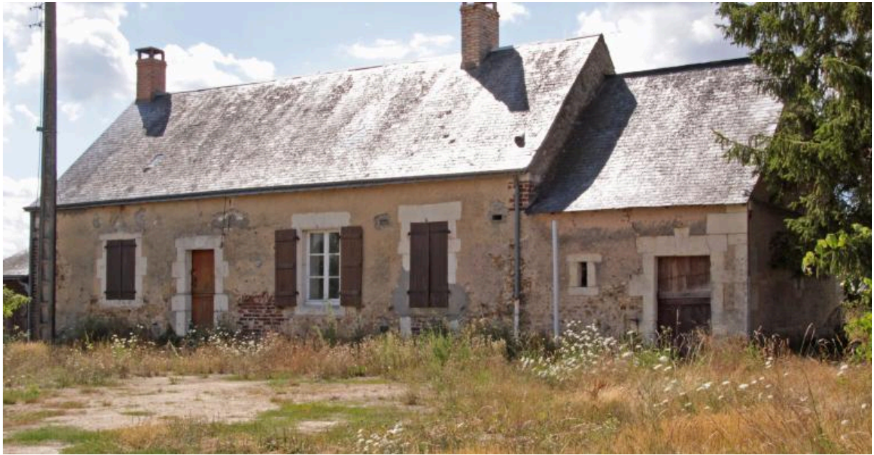
La maison : façade antérieure sur cour.
