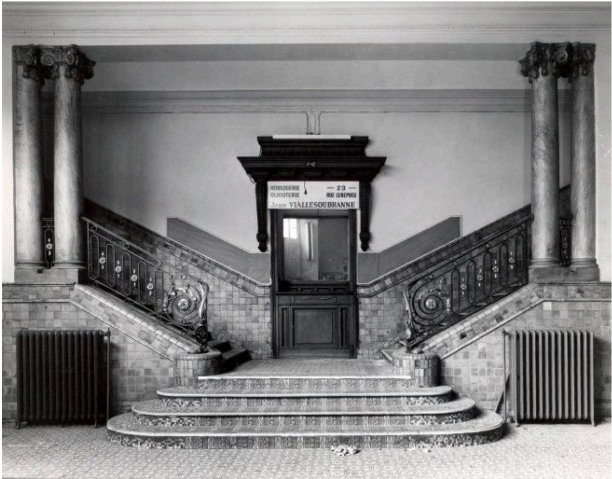
Vestibule, l'escalier d'honneur.
