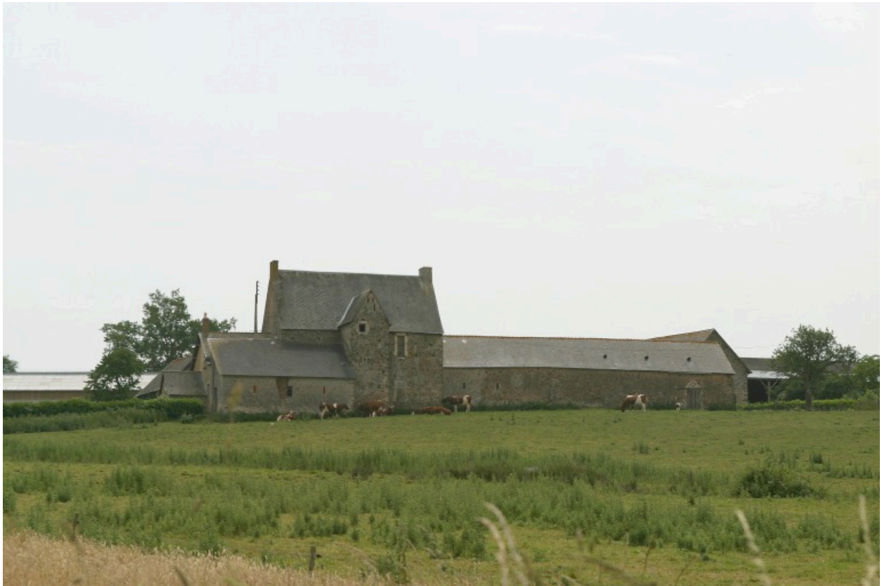
Vue d'ensemble depuis la route nationale, au nord : le logis et l'étable.
