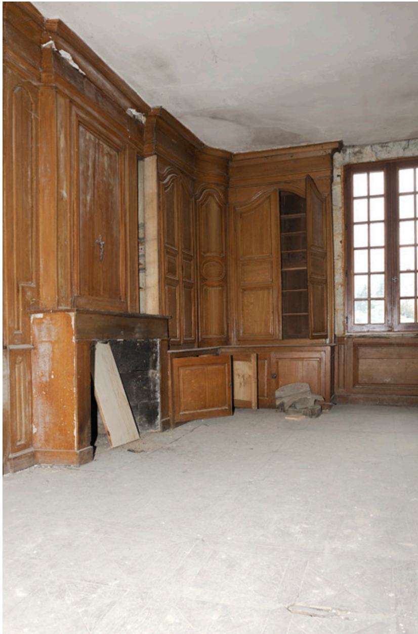
Etage, salle lambrissée, angle sud-ouest (1).
