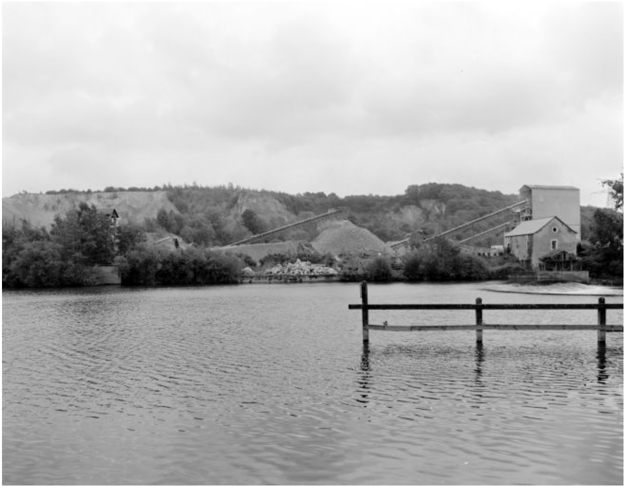
La carrière et le moulin vus de la rive droite en amont.
