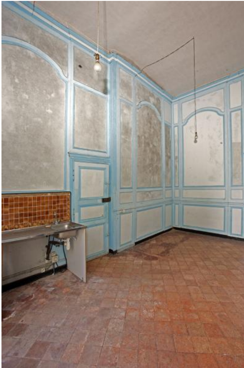
La petite chambre du pavillon sud.
