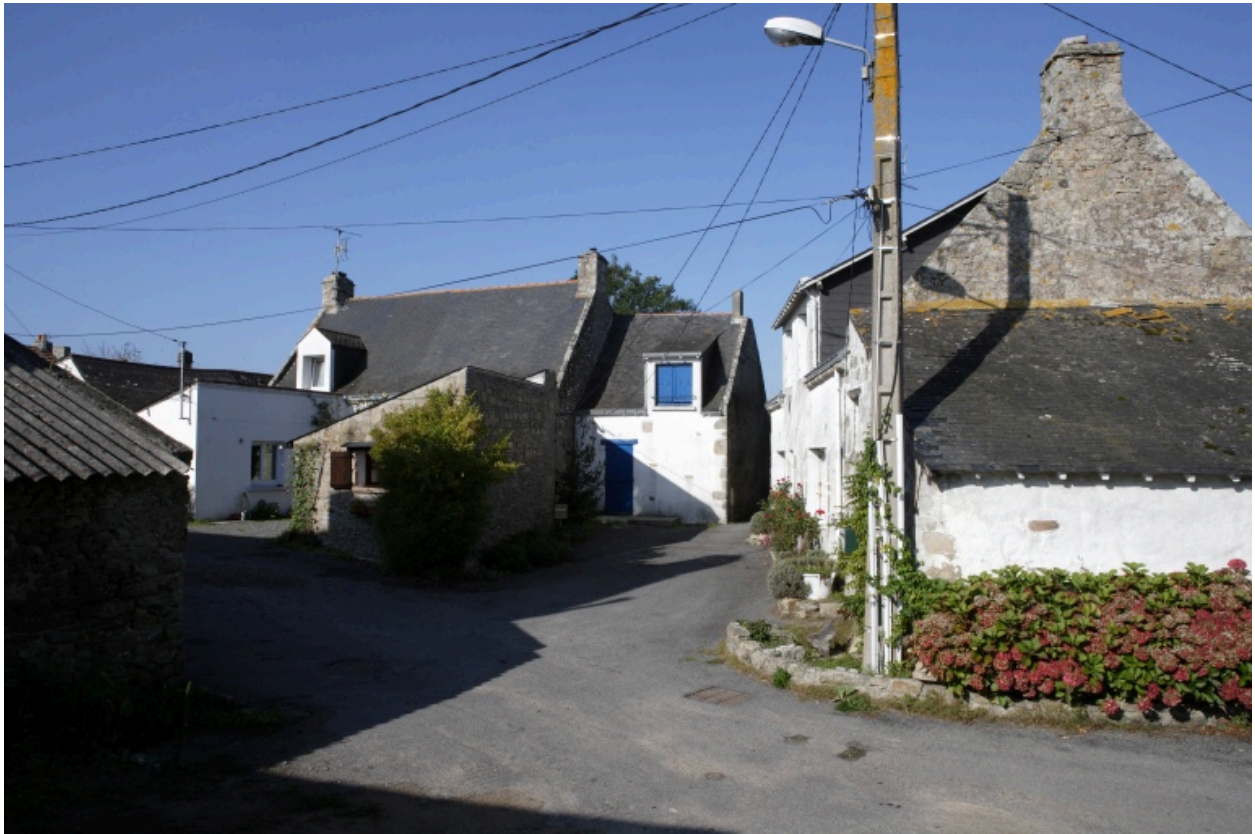
Vue d'ensemble de la rangée depuis l'est.
