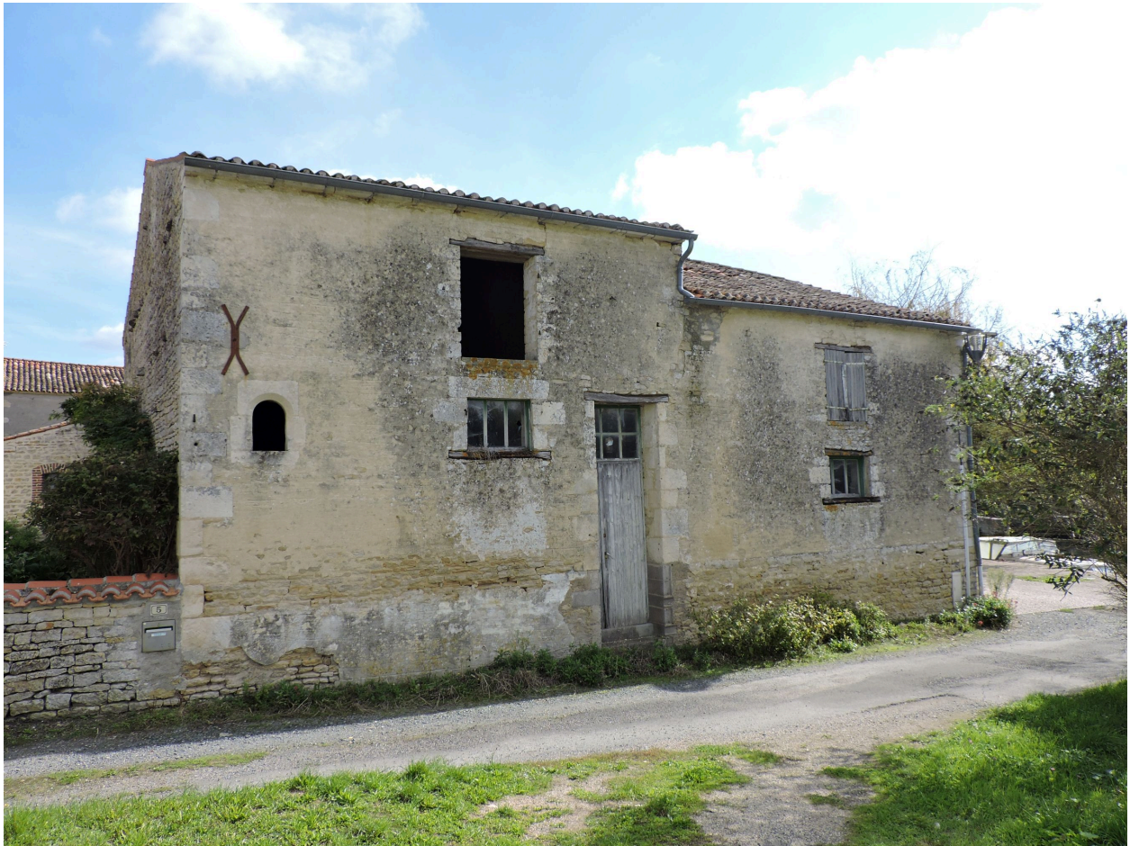
Les remises vues depuis l'ouest.
