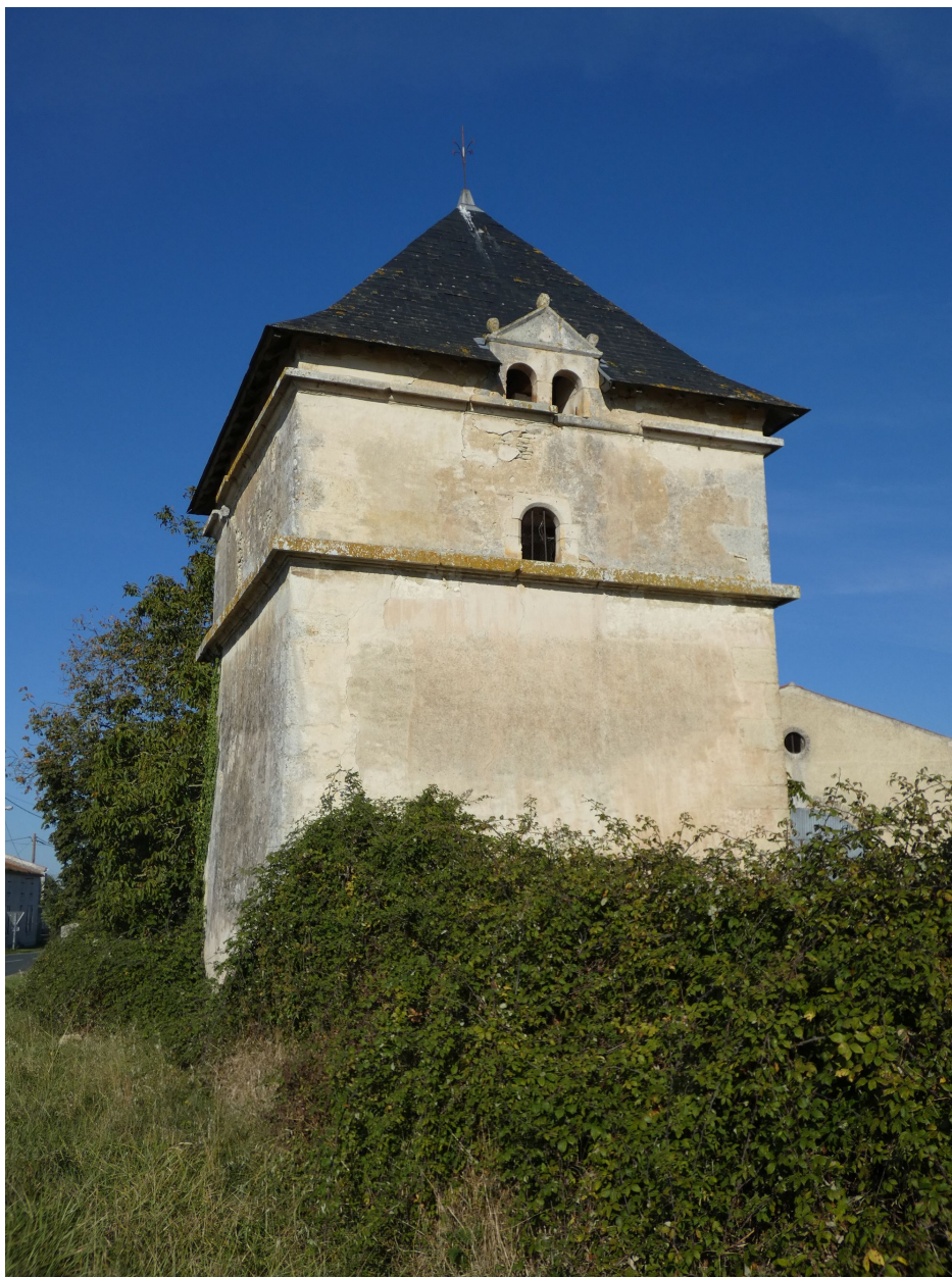
Le pigeonnier vu depuis le sud-est.
