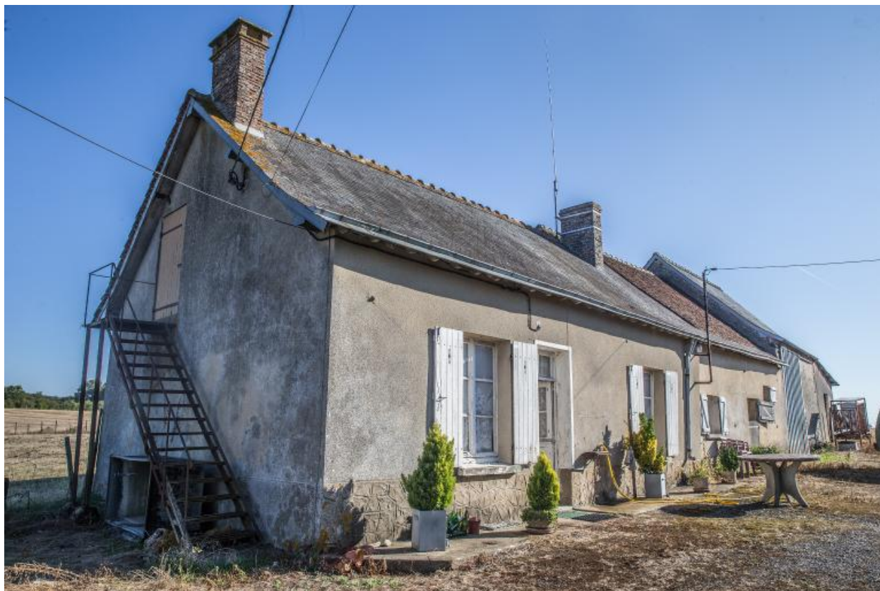
Ferme 2, vue de volume du logis avec façade antérieure.
