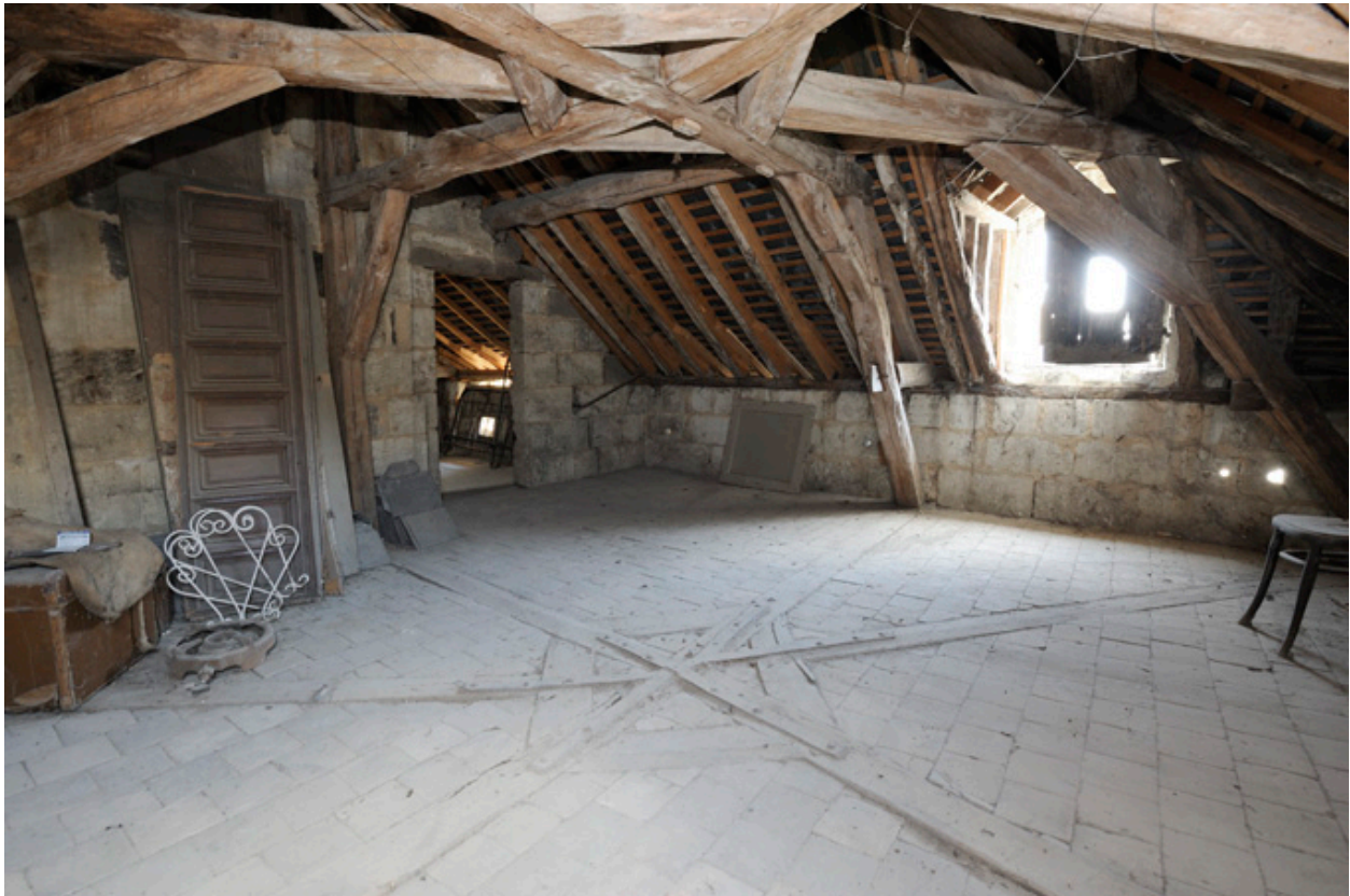
Charpente et comble du corps à l'angle des rues des Masques et Robert d'Arbrissel : enrayures des entrails et faux-entrails, en regard.
