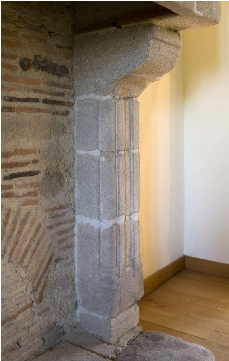
Pavillon. 1er étage. Salle nord, Détail du piédroit de droite de la cheminée.
