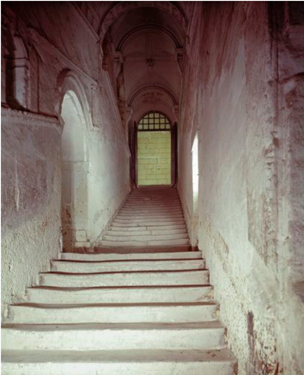
Aile est, escalier monumental du dortoir (1542-1546), avant restauration.
