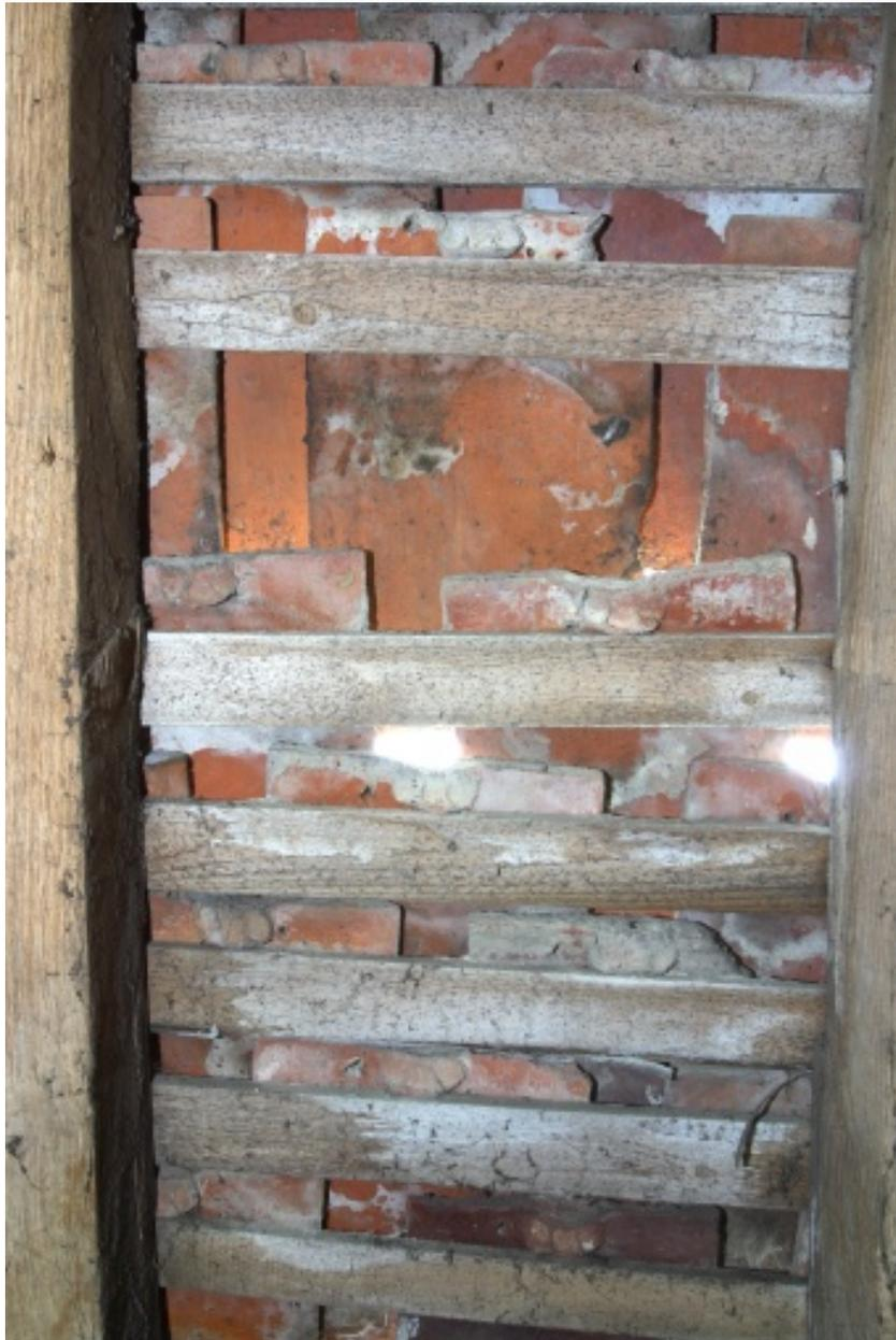
Comble de la dépendance contigüe au logis : vue de détail du voligeage et de la couverture de tuile.
