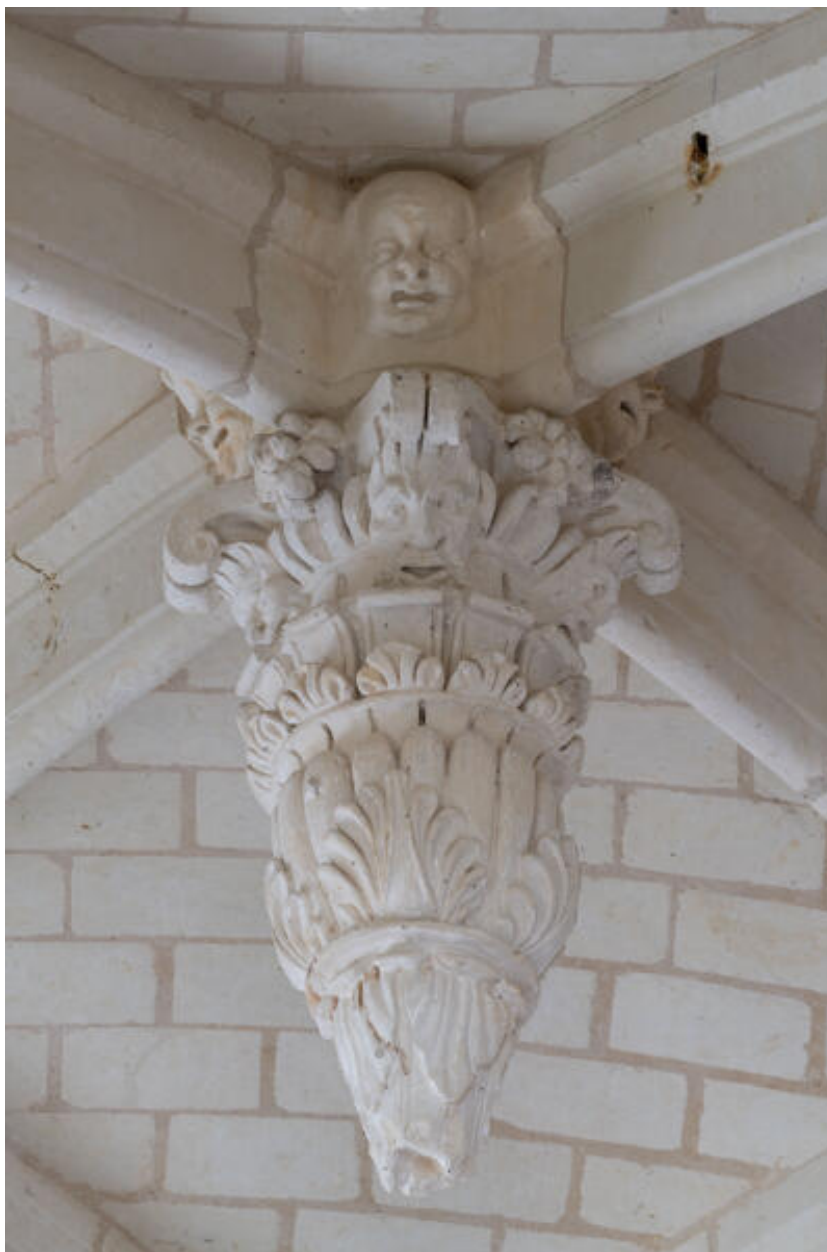
Chapelle latérale, travée ouest : clef pendante au centre de la voûte.
