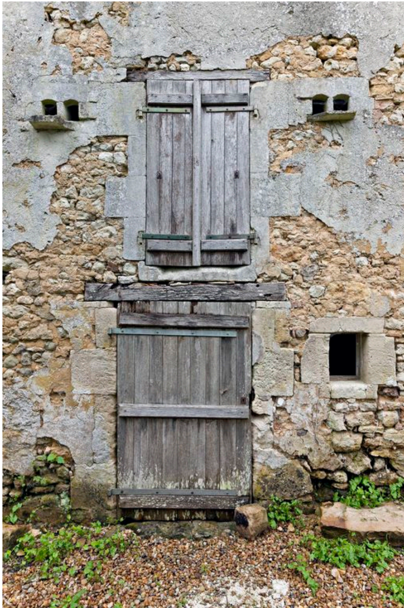
Détail des baies du moulin
