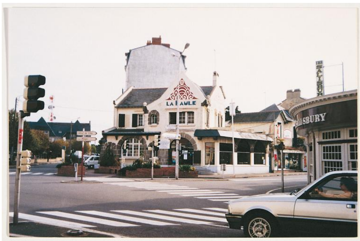
Façades nord et ouest du syndicat d'initiative de La Baule.
