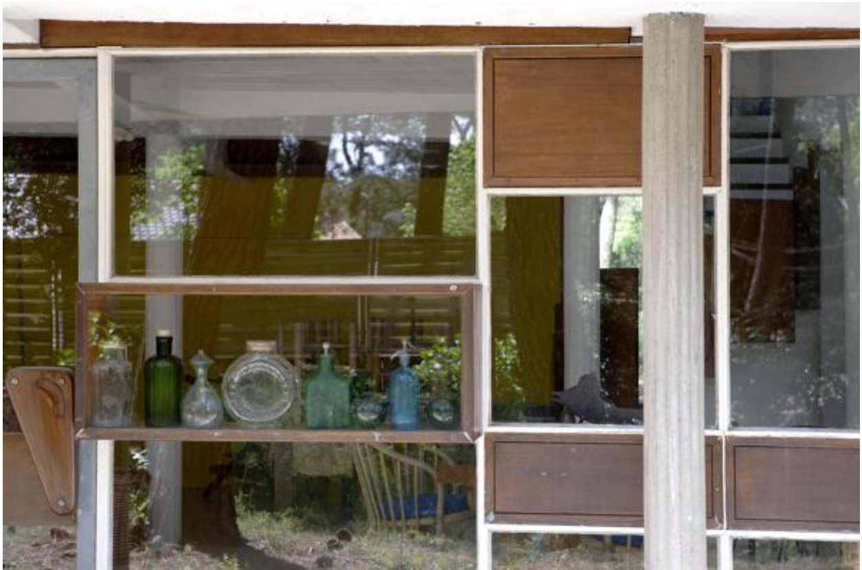
Détail de la façade vitrée, avec casiers de rangement en bois.
