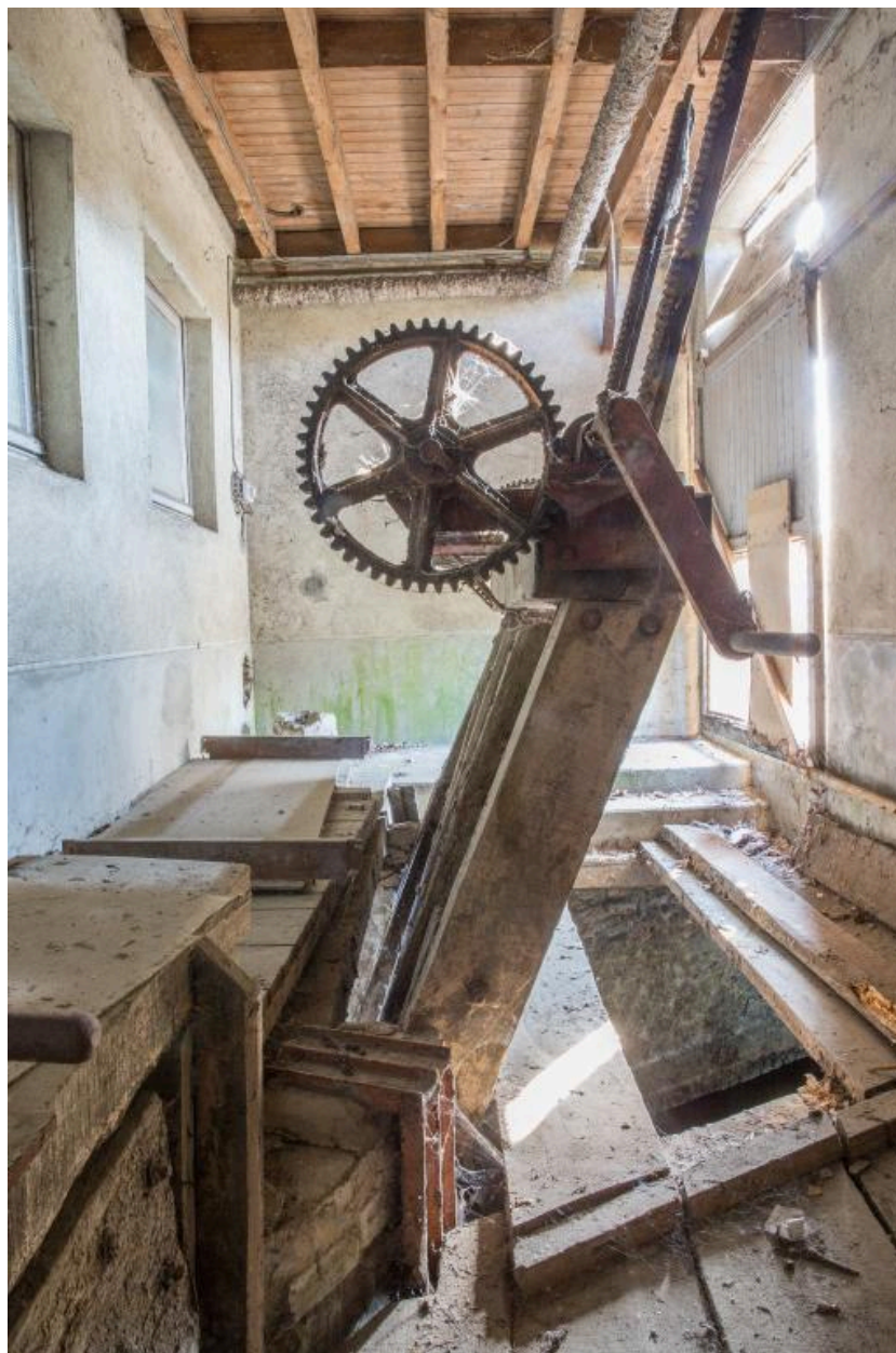
Les anciennes vannes sur le Dué.
