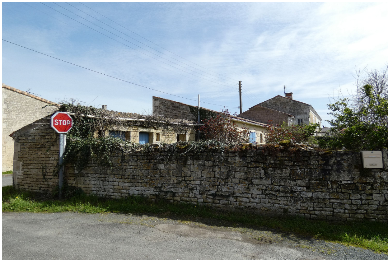
Le toit à porcs dans l'angle nord de la ferme, rue du Mouton.
