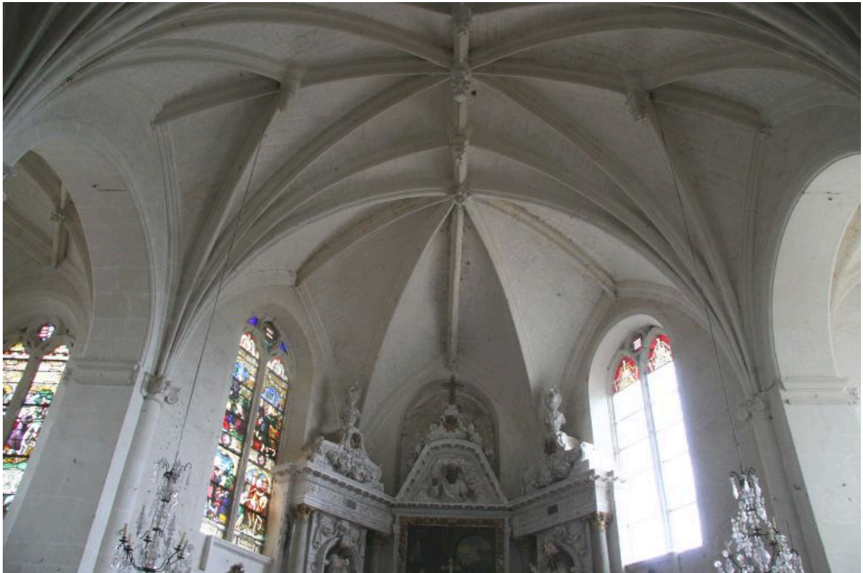
Voûtes d'ogives bombées du chœur.
