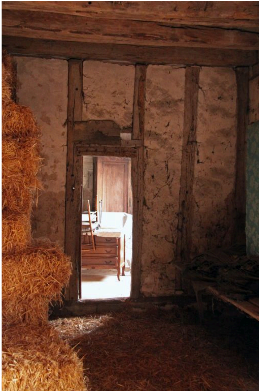
le logis, 1er étage : cloison en pan-de-bois.
