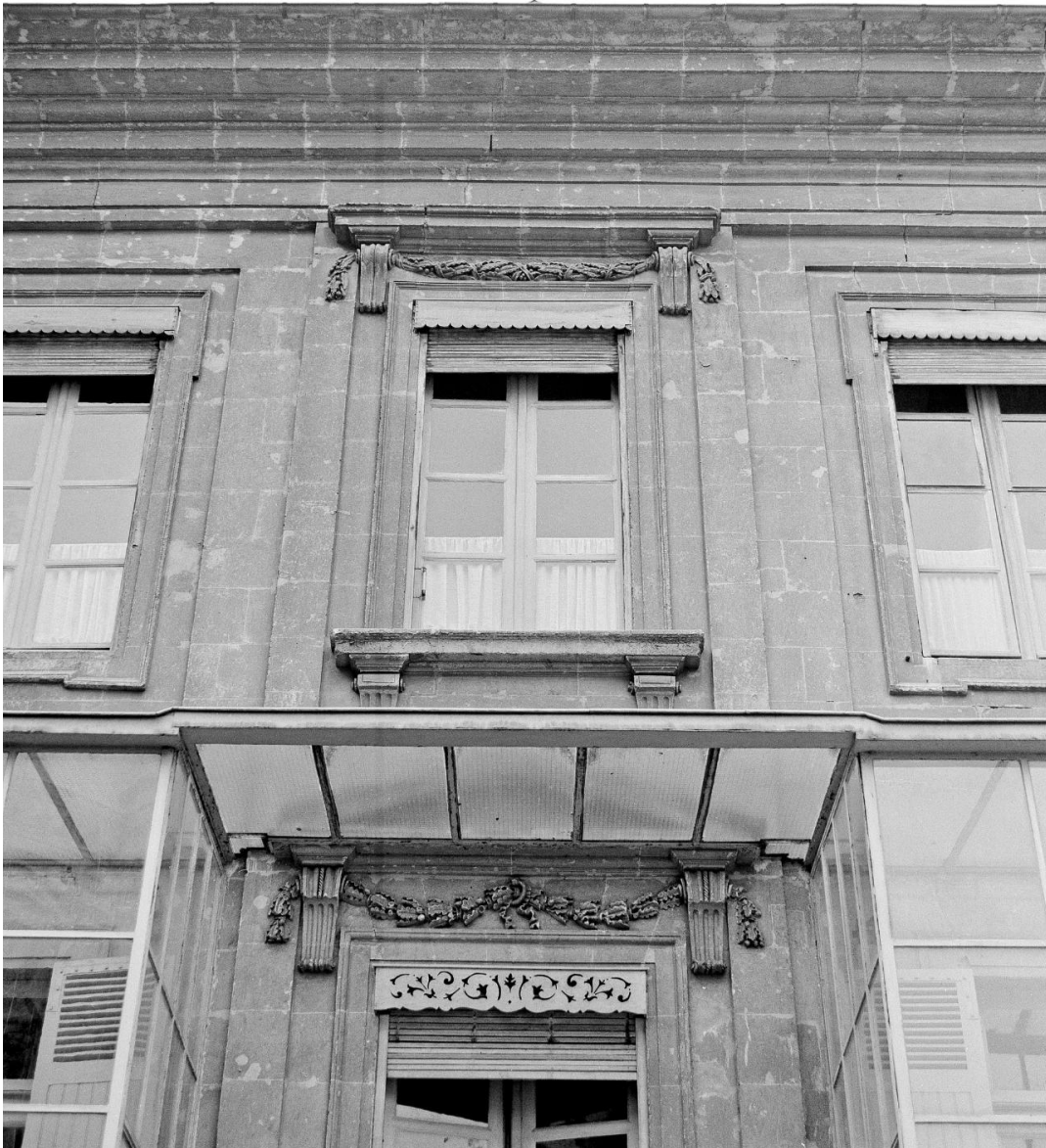
Corps principal, façade antérieure, travée centrale, 1er niveau.
