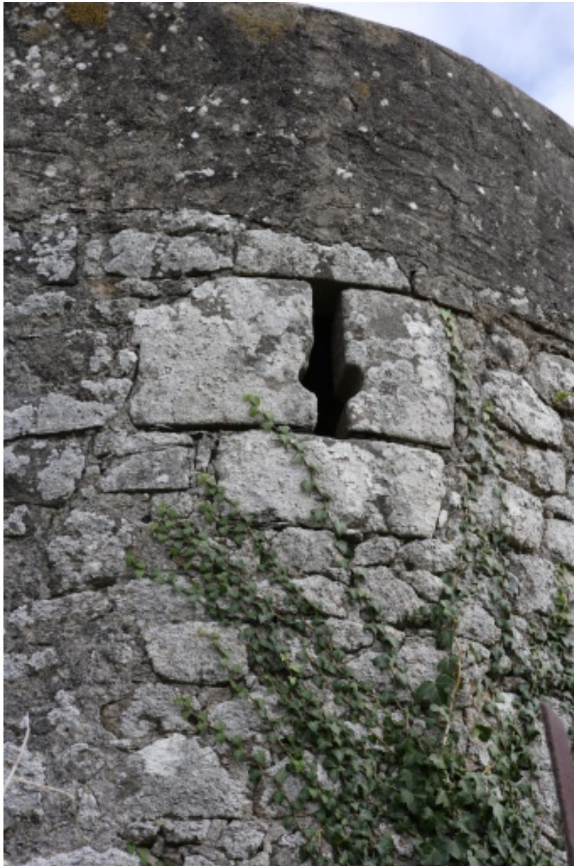
Mur de clôture. Tour d'angle sud-est. Détail d'une embrasure de tir.
