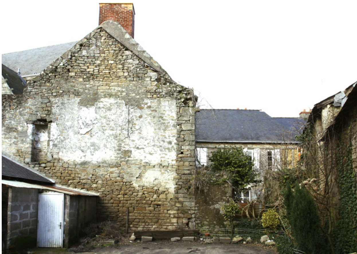
Elévation ouest de l'aile nord.
