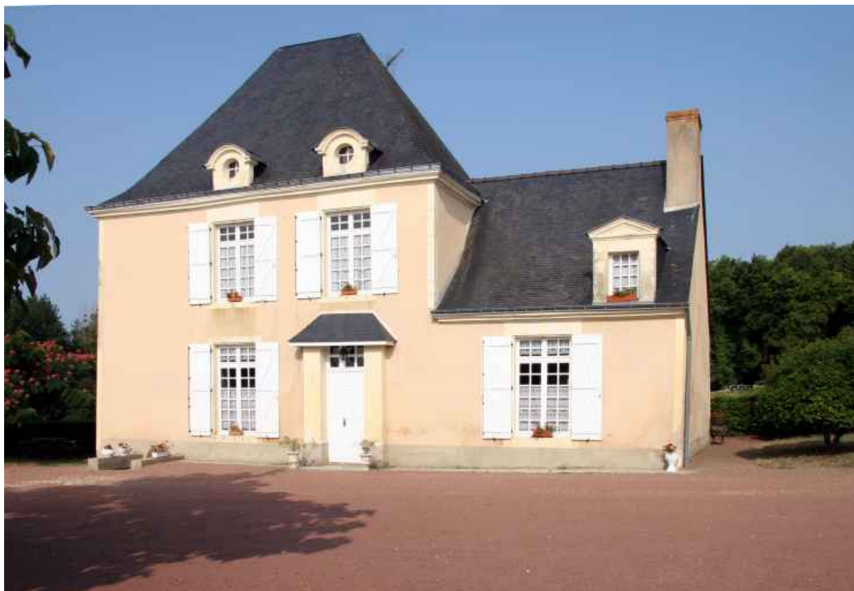
Façade antérieure sur cour.
