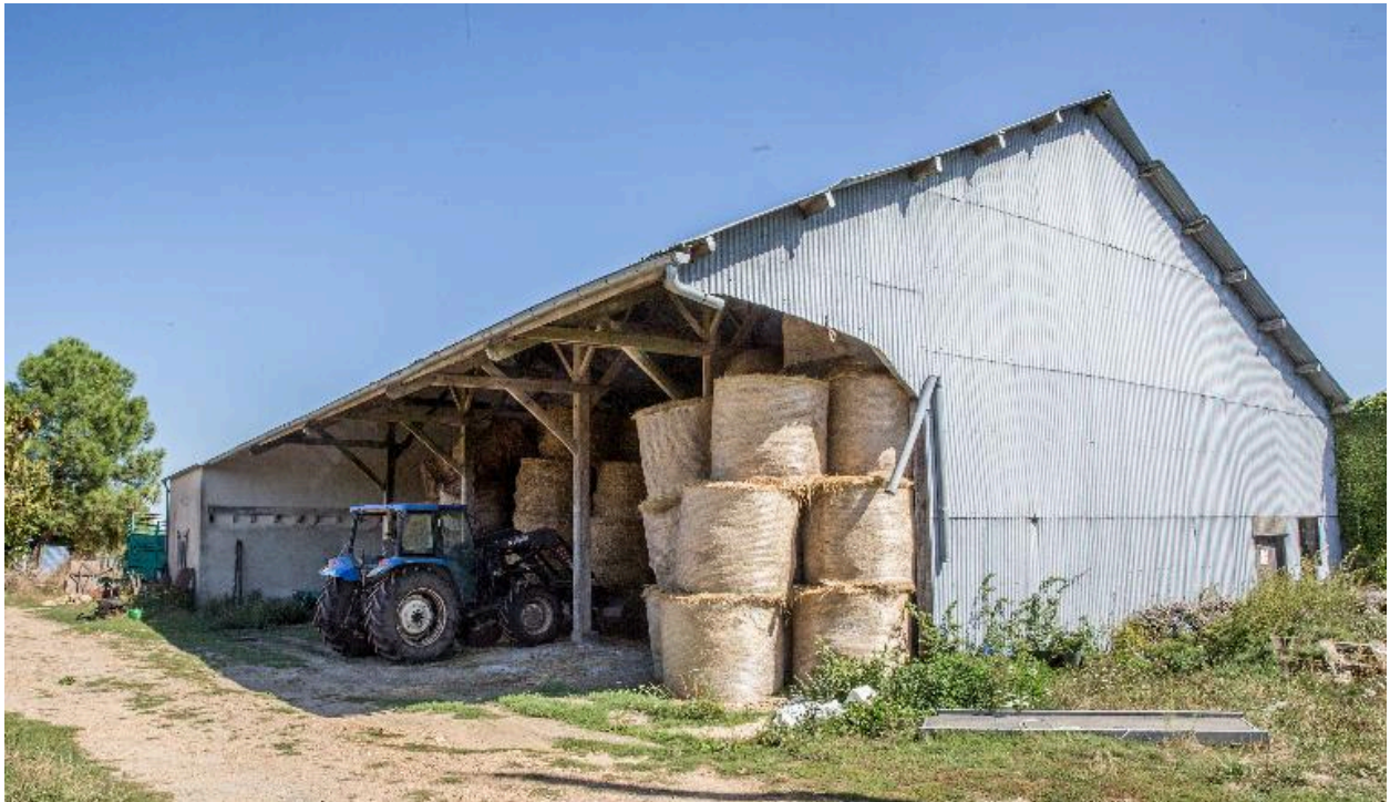
Hangar agricole à charpente en bois.
