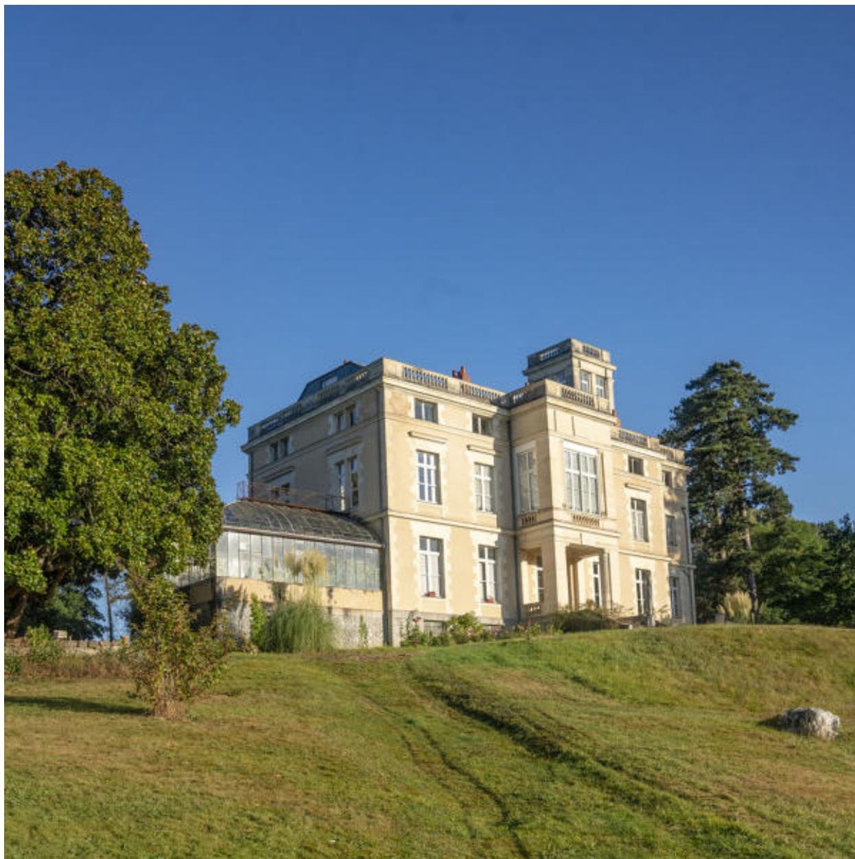
La façade antérieure du château.
