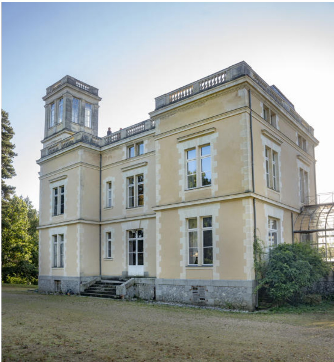
La façade postérieure du château.
