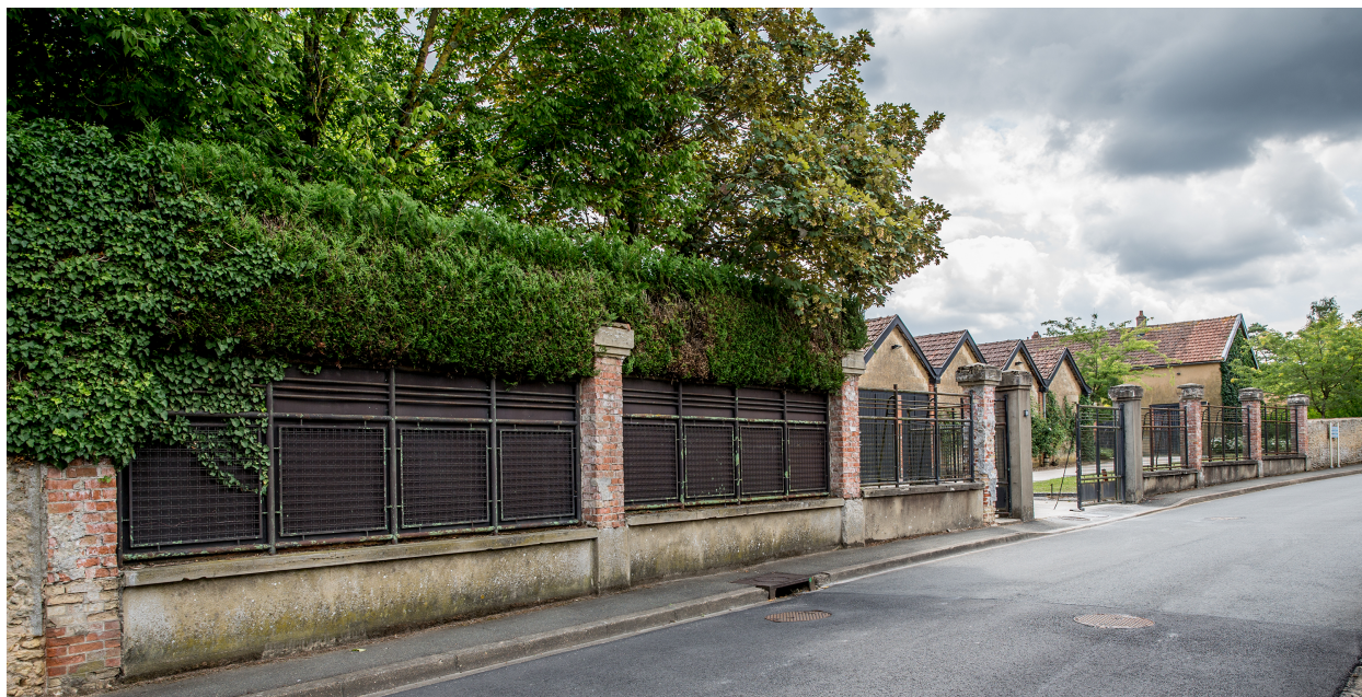
Le mur de clôture sur la rue de la Jatterie.
