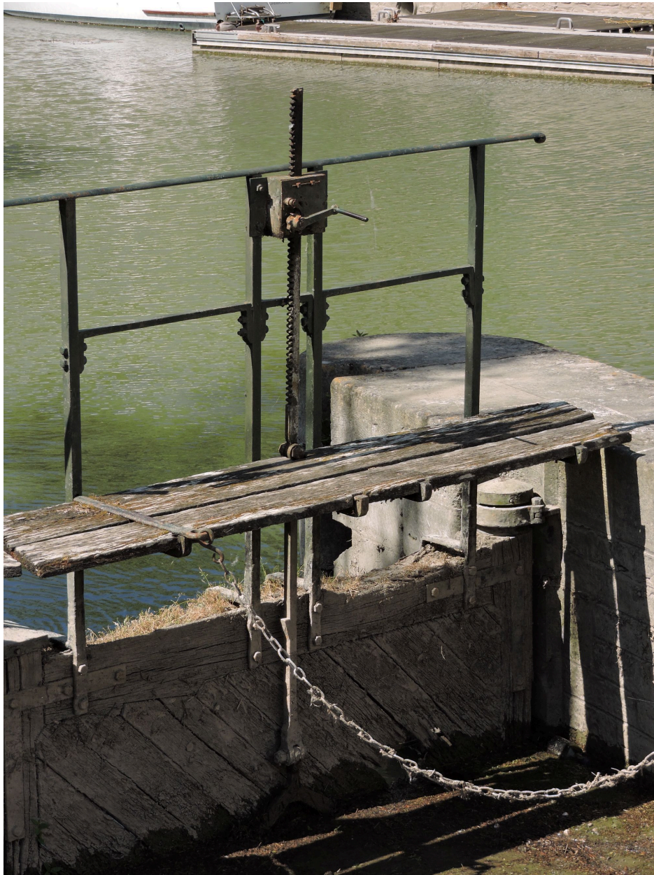
Détail de la porte aval de l'écluse, avec sa ventelle.
