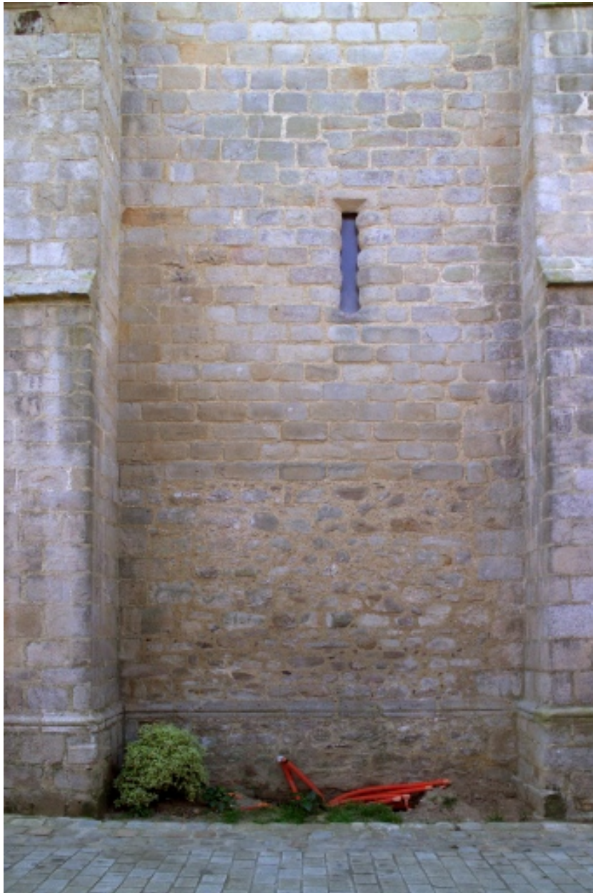
Mur nord, détail de la première travée.
