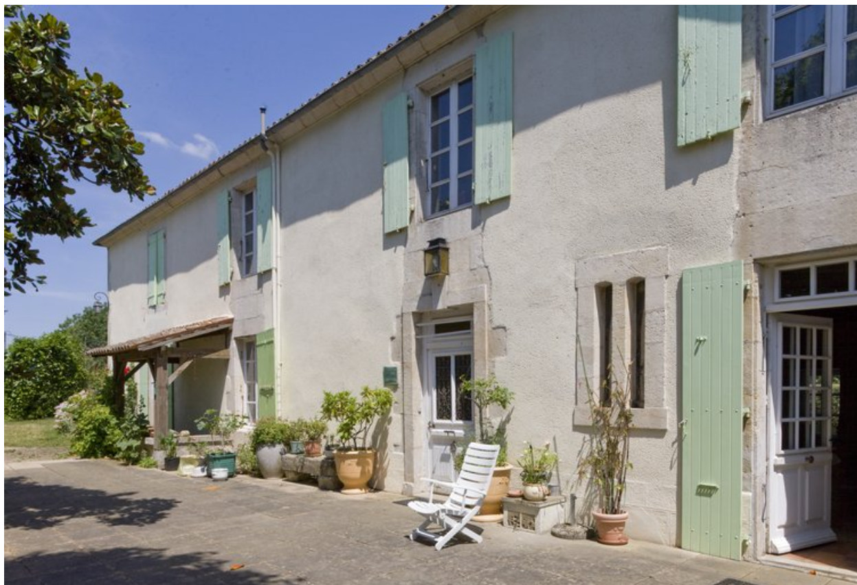
Façade ouest : partie nord.
