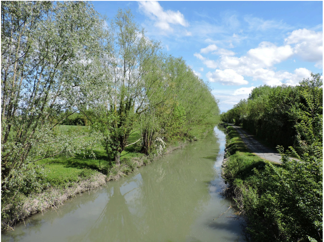
Le canal de Bourneau au pont de la Pichonnière, vu en direction du sud-est, vers l'amont.
