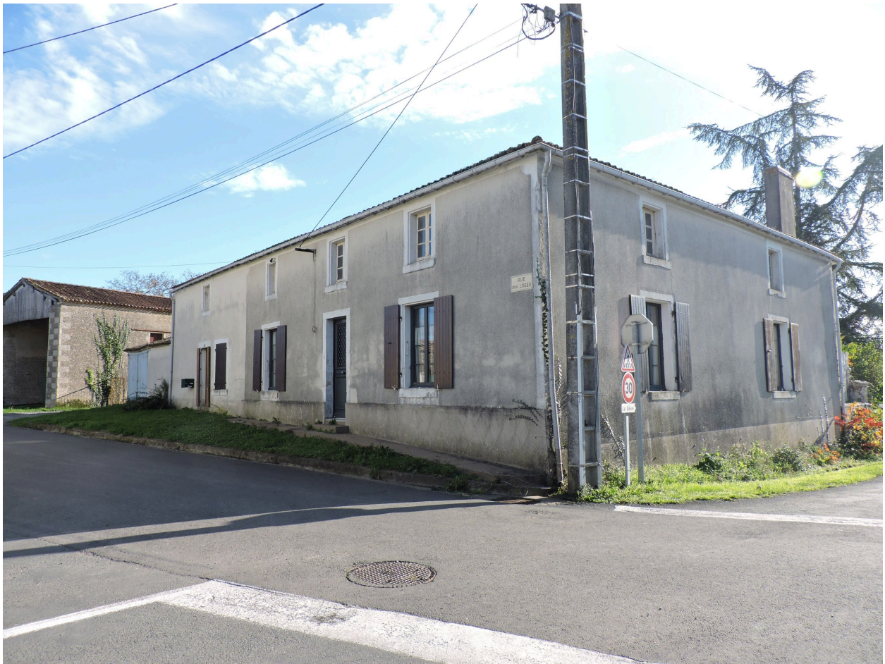
Le logis vu depuis le nord-ouest.
