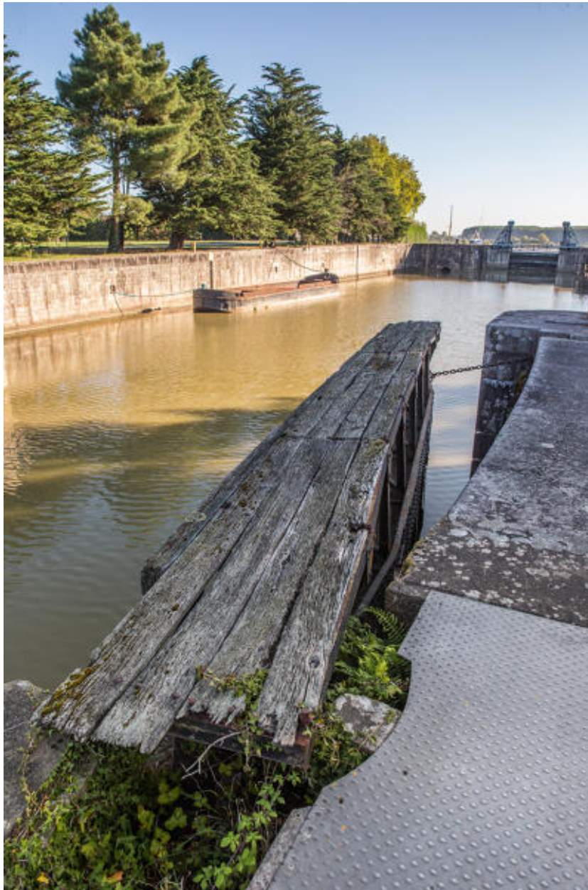
Vue de détail d'une porte de la tête aval de l'écluse (1/2).
