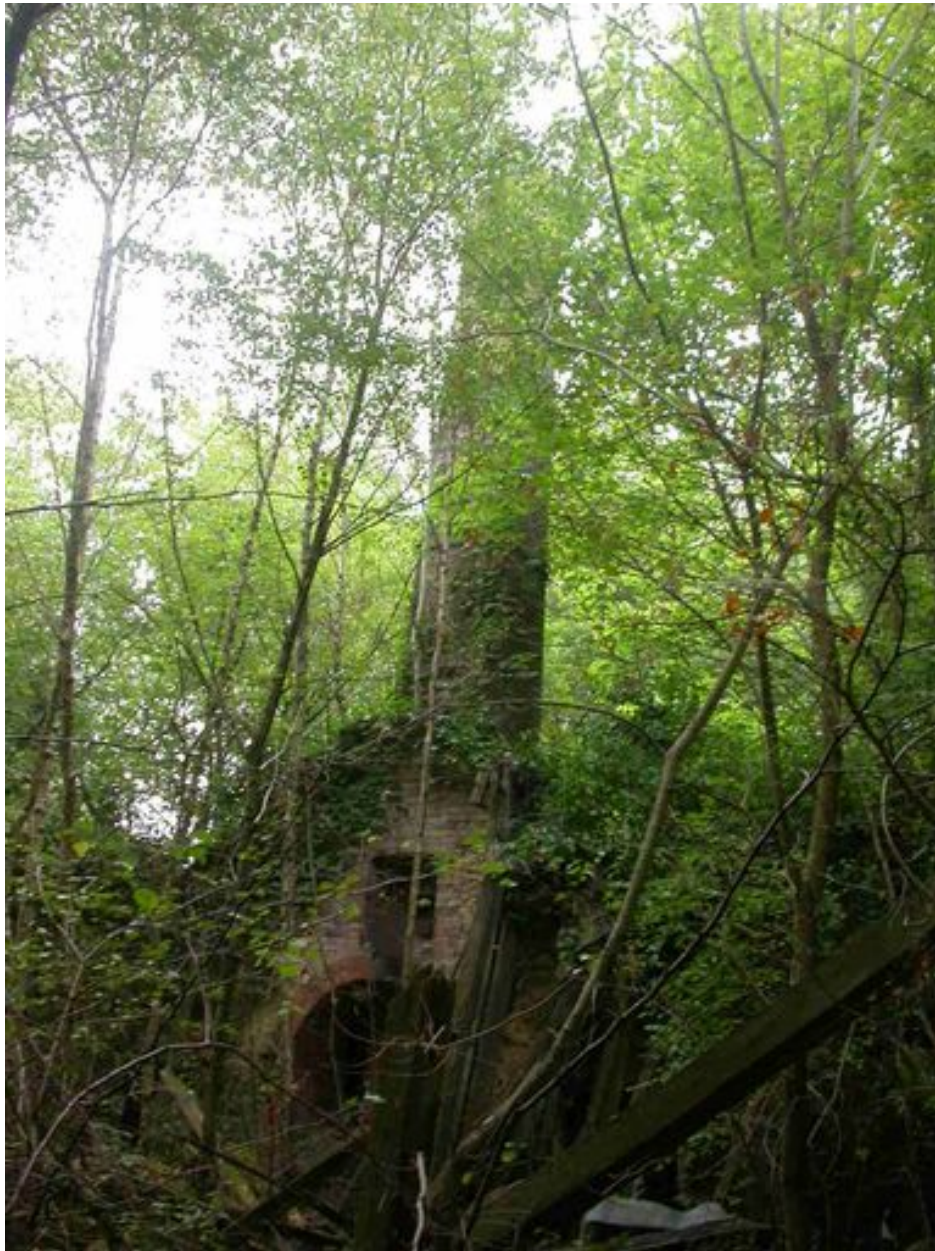
Une des deux cheminées des fours de la verrerie de Coudrecieux.
