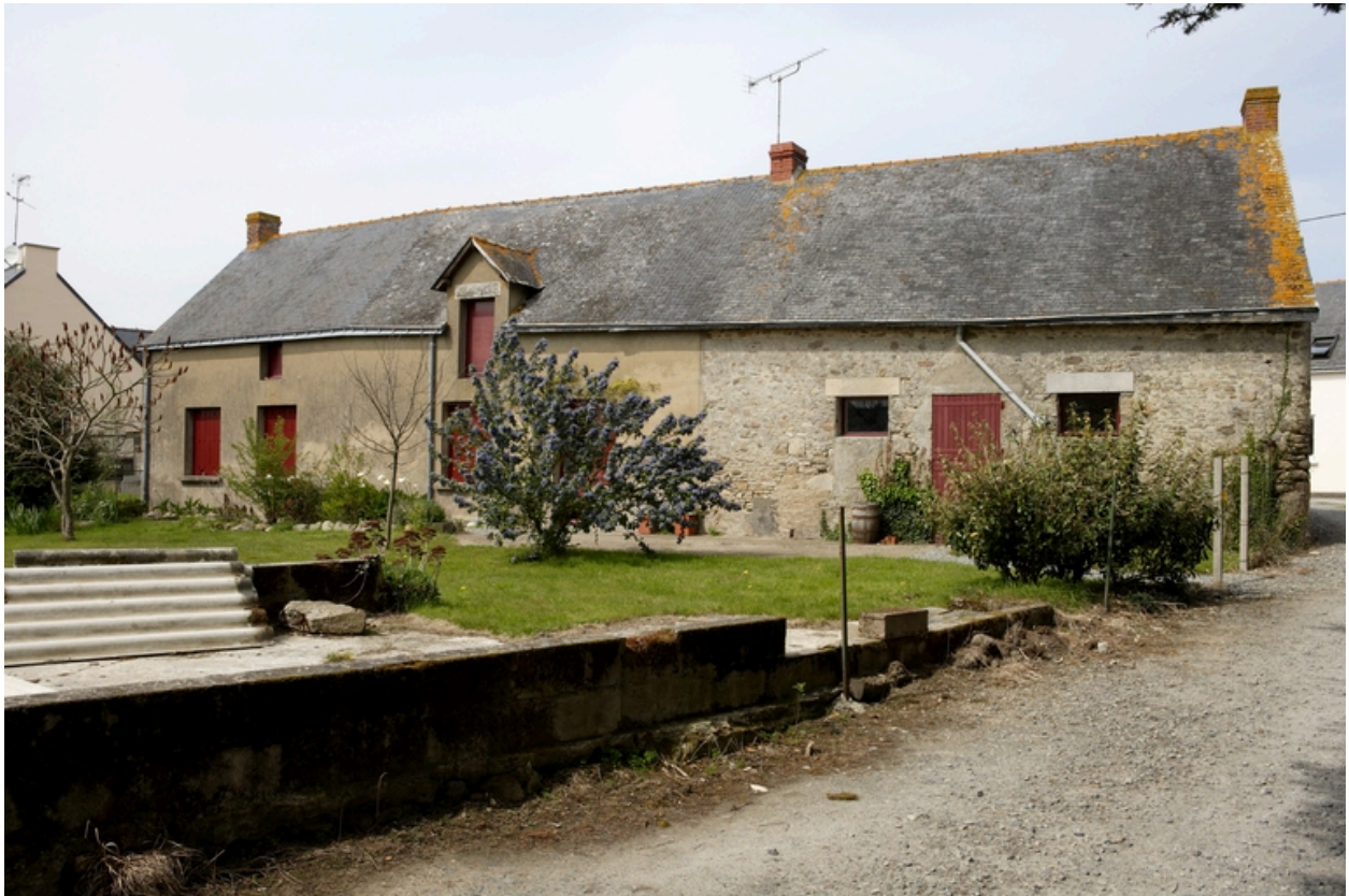
Vue de la façade arrière.
