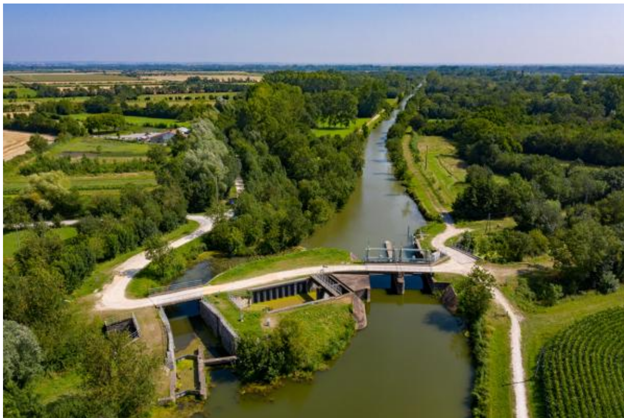
Vue aérienne de l'aqueduc depuis le sud.
