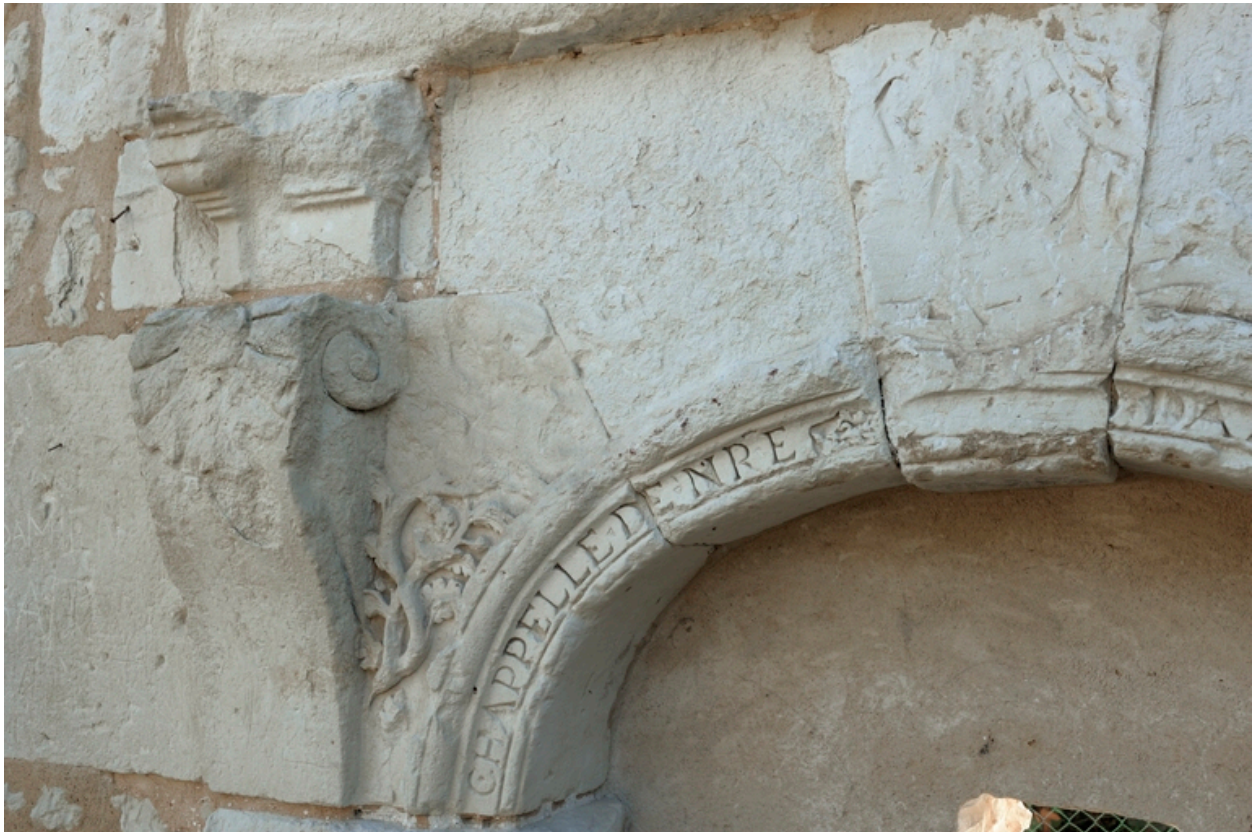
Détail du couvrement de la porte.
