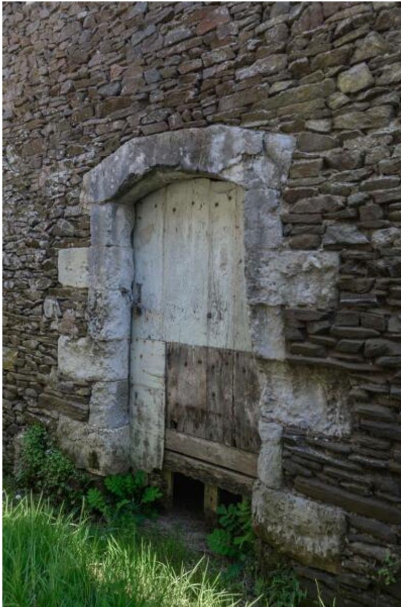
10 rue des Mauges. Détail d'une porte couverte en arc segmentaire.
