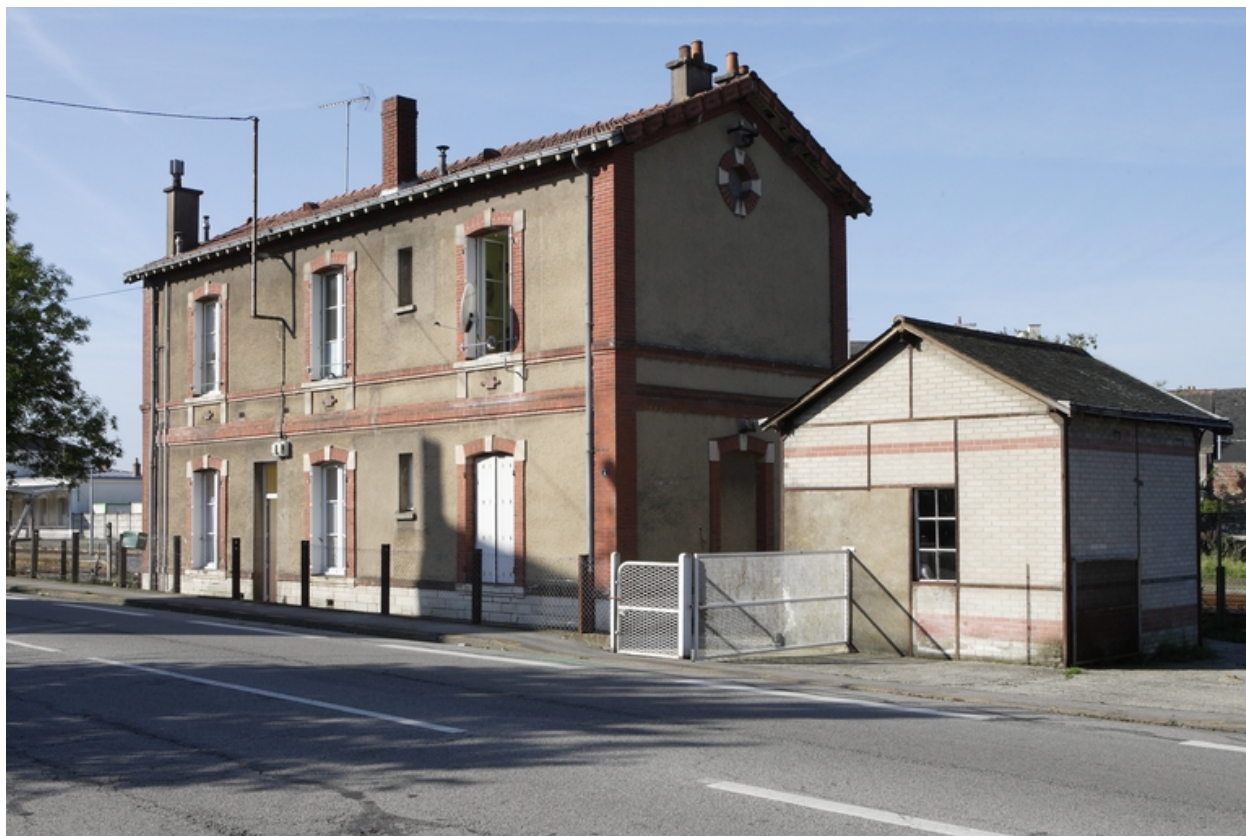
Logement de fonction, côté rue.
