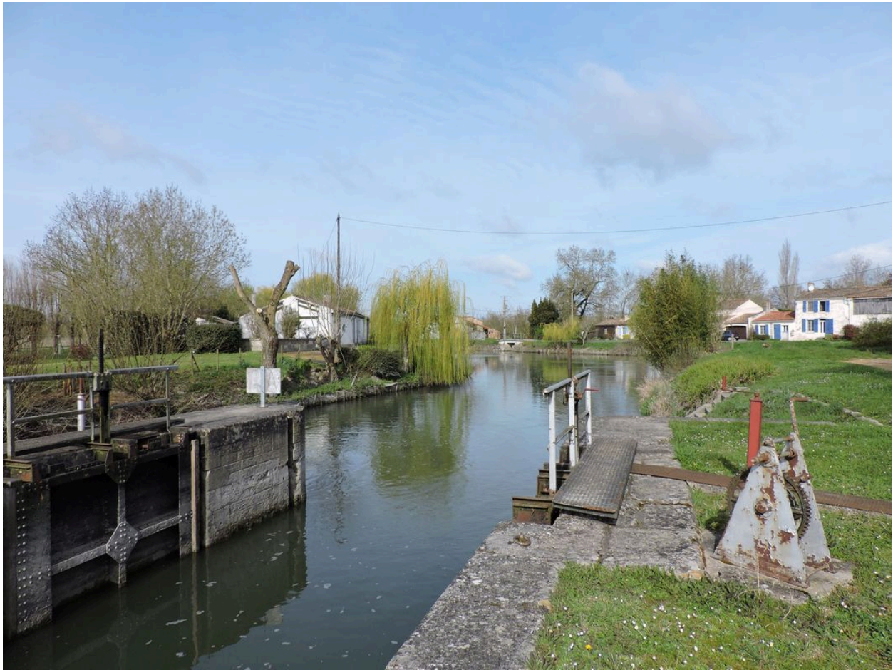
L'écluse vue en direction de l'aval, vers le nord-ouest.
