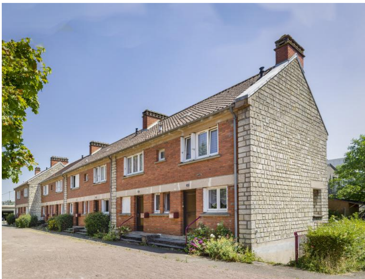
Vue de la façade des maisons individuelles E2 depuis les espaces verts.
