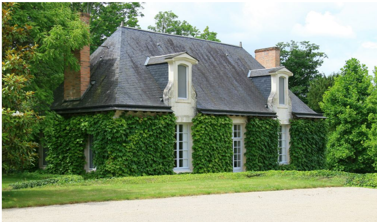
Logement situé face au château, au sud-ouest : façade nord.
