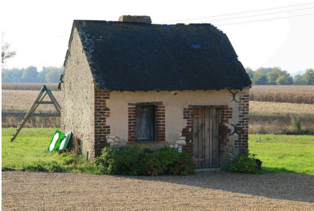
La buanderie : façade sur cour.
