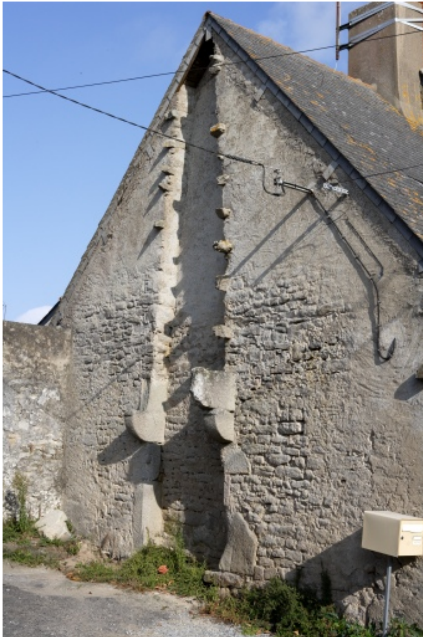
Vue de la cheminée du 1er logement.
