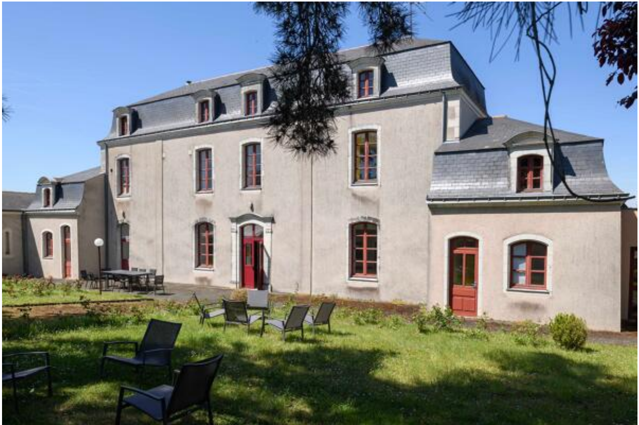
Vue de la façade sud.
