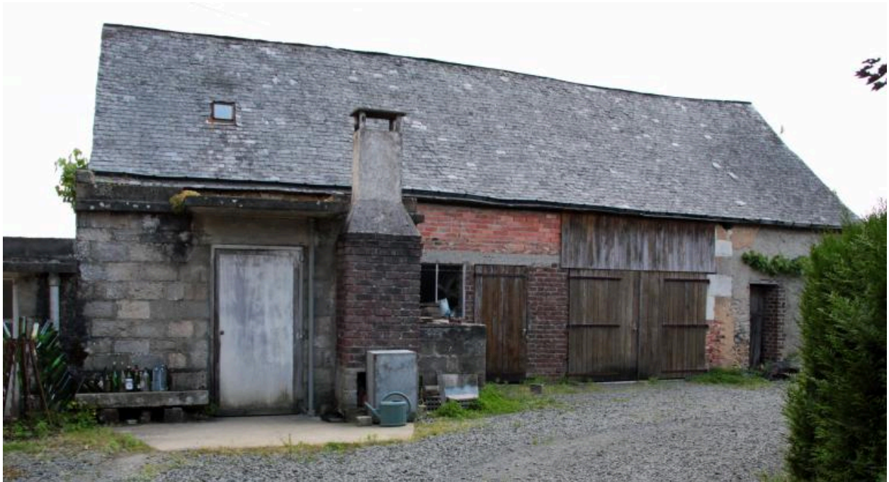
7, rue de St-Hubert : dépendance (ancien atelier de maréchal-ferrand).
